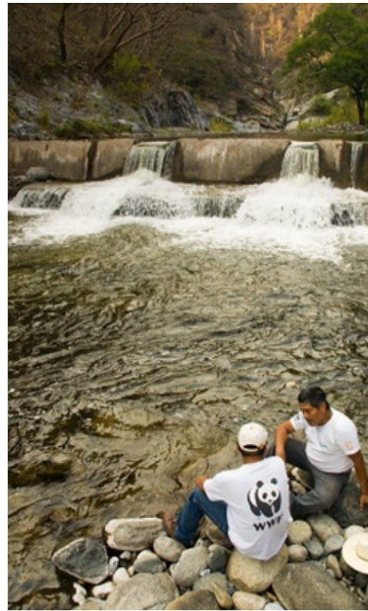
Presas de captación para consumo domiciliario. WWF, 2007.
